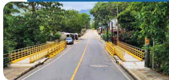
Pasarelas Puente El Toro
