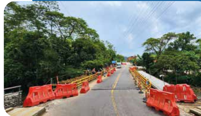
Pasarelas Puente La Sardinata
