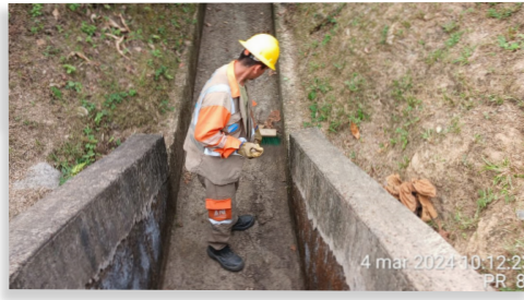
Limpieza de obras hidráulicas longitudinales y transversales
