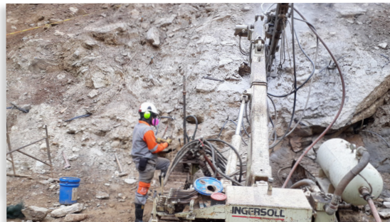
Actividad perforación para instalación de anclajes UF 1
