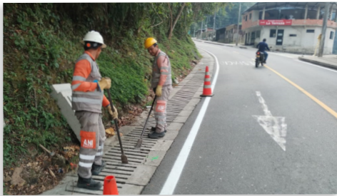
Limpieza de obras hidráulicas longitudinales y transversales
