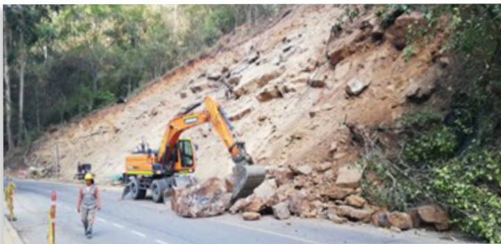
Conformación de terrazas y perforación anclajes para estabilización de talud PR 32+200 paso seguro 6
