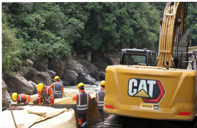
Actividades de instalación de geocontenedores PR56+100 UF4
