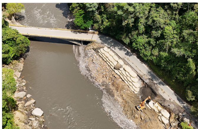
Actividades de instalación de geocontenedores, sector Piedra Campana Pr56+100
