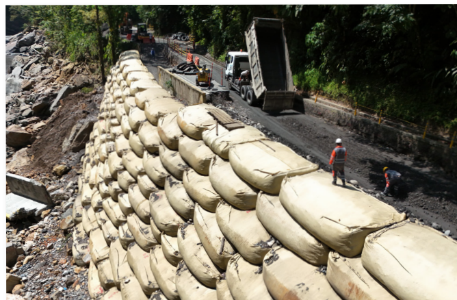
Actividades de instalación de geocontenedores PR56+100 UF4
